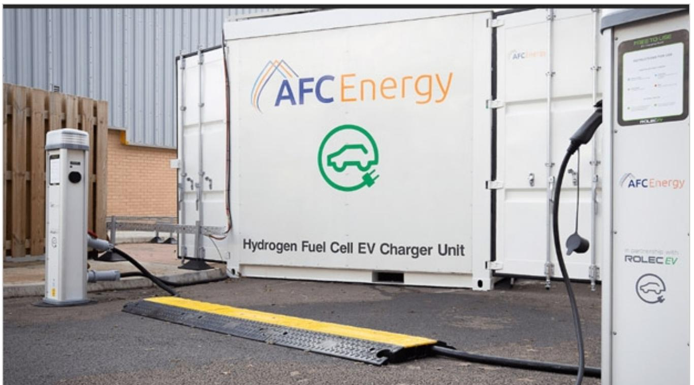
La British AFC Energy ha desarrollado una estación de carga modular alimentada por hidrógeno para vehículos eléctricos. El sistema fuera de la red es autónomo y está diseñado para cubrir áreas con poca cobertura de red con carga rápida "en cualquier lugar que se necesite".
