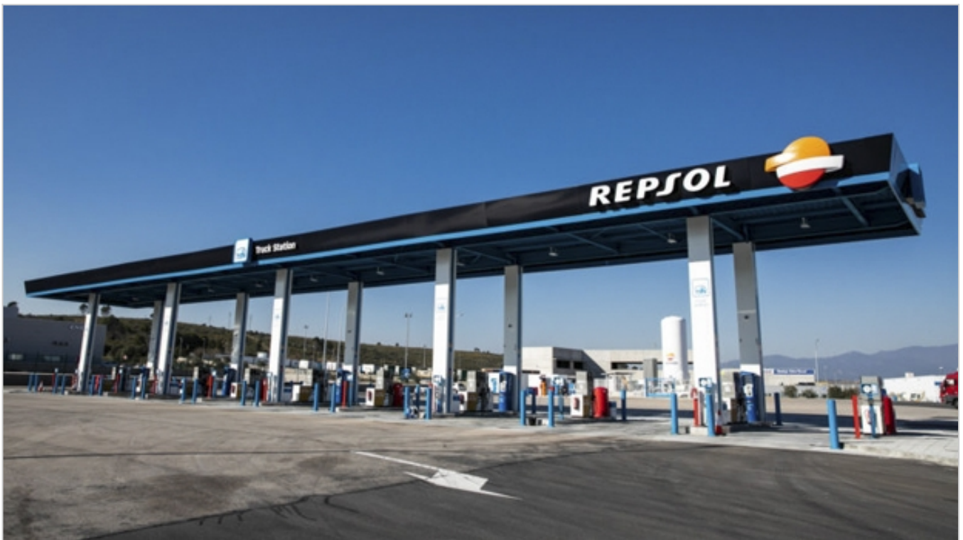
Estación Repsol de GNL y GNC en España. | © ECO-GATE
